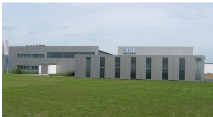
Frontansicht Pieper Oberflächentechnik
