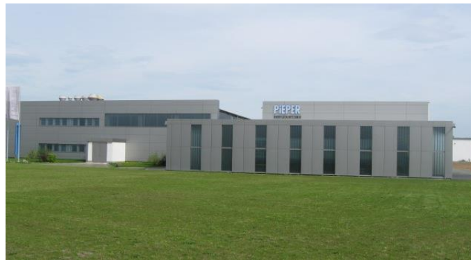
Frontansicht Pieper Oberflächentechnik
