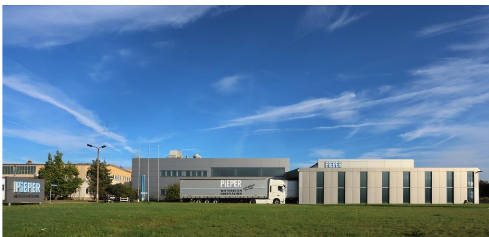
Frontansicht Pieper Oberflächentechnik
